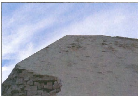
Obložení přivážené z lomů v Tuře se dodnes zachovalo na Lomené pyramidě krále Snofrua, jižnější z jeho dvou pyramid v Dahšúru.
