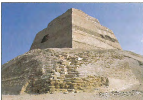
Původní severozápadní nároží a obnažené jádro sesuté pyramidy u Médúnu
