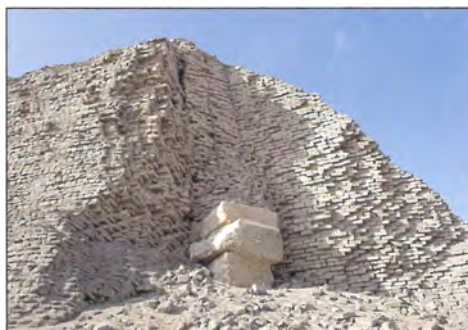
Výčnělek vápencového křížového jádra cihlové pyramidy panovníka Senusreta II. v Láhúnu
