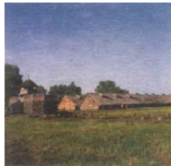
Rekonštrukcia dlhých domov
