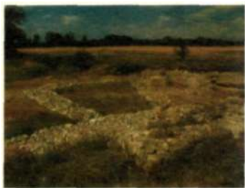
Základy rohovej veže v Iži
