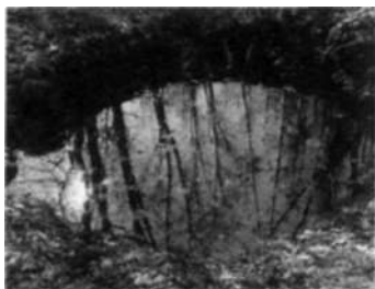
Cisterna je práčne vysekaná do skaly
